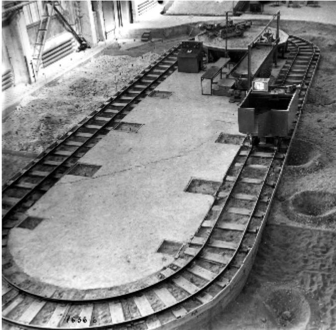
**Рисунок 4. Испытательная трасса на закрытом полигоне лаборатории ходовых испытаний**
