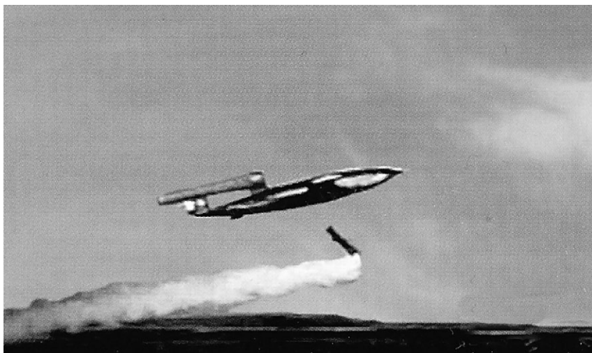
Взлет Фау-1 с пусковой рампой. Видно падение разгонного блока
