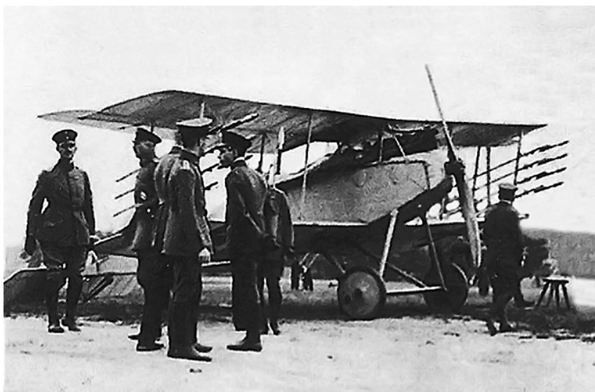
Немецкий истребитель-биплан, вооруженный пороховыми ракетами
