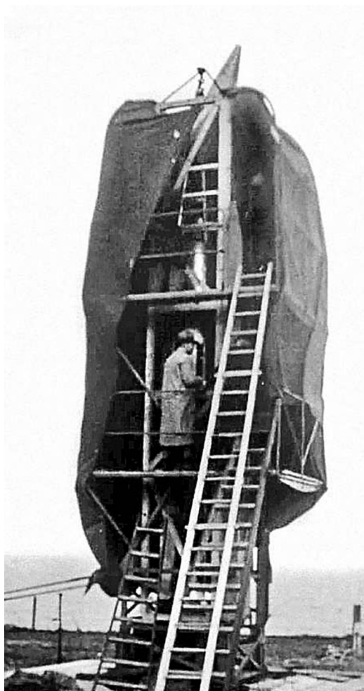
Стенд для испытаний ракеты А2. Первые ракеты серии «Агрегат» запускали по наклонной траектории
