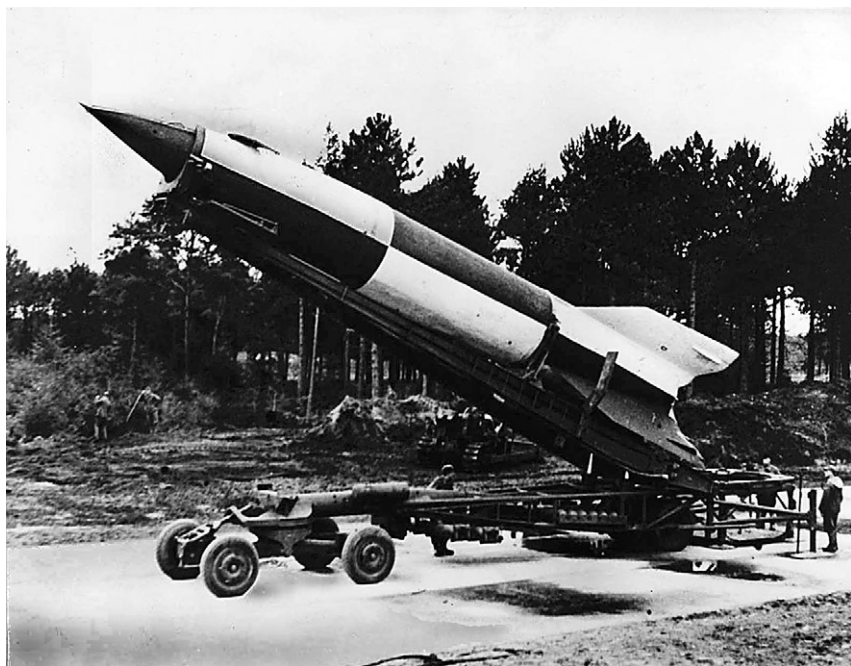
Установка A4 на стартовой позиции в районе Куксхафена
