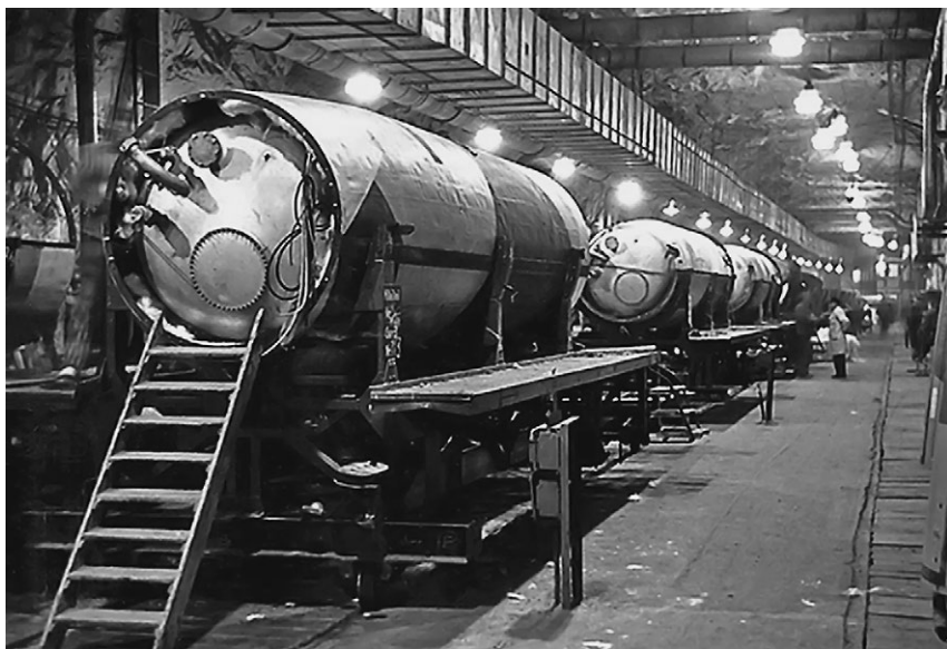
Топливные отсеки ракет А4 в сборочном цехе завода «Миттельверк»
