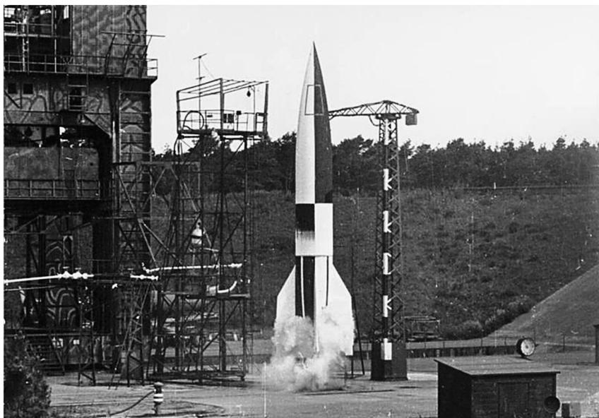
Запуск двигателя А4. Стенд № 7 (лето 1943 г.)
