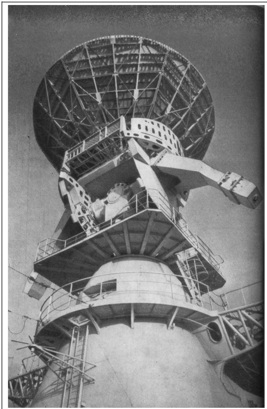
Двухзеркальная квазипараболическая антенна Центра дальней космической связи (диаметр основного зеркала более 70 метров).
