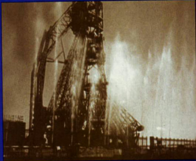
Строительство первого стартового комплекса
