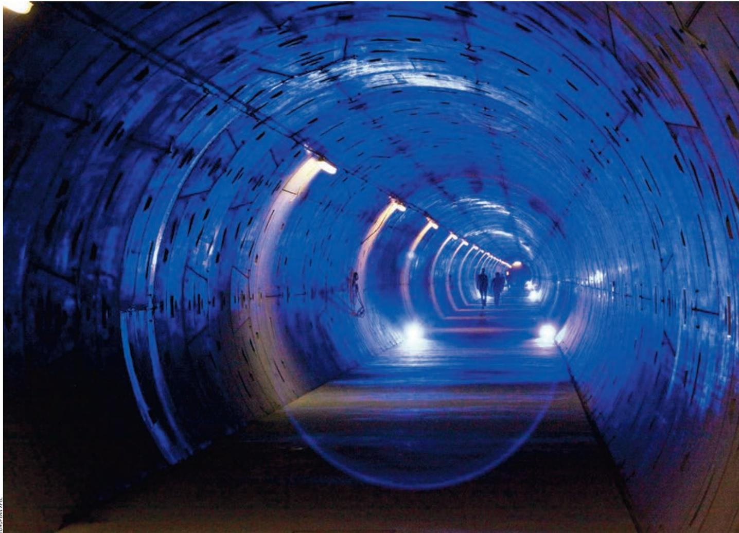
DESY (этой аббревиатурой назван немецкий электронный синхротрон — ускоритель элементарных частиц) на окраине города — в местечко Шенефельд. Там построена подземная экспериментальная лаборатория с залом общей площадью 4500 кв. м — это примерно как гамбургский стадион «Имтех Арена» на 57 тысяч зрителей, только упрятанный на глубину 14 метров. Причем тоннель длиной 5,7 км должен быть идеально прямым — лазерный луч, понятно, никаких искривлений не признает.
