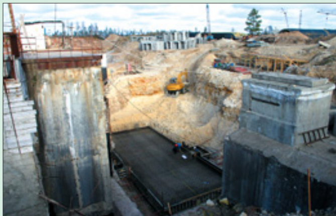
Заливка фундамента для башни обслуживания
