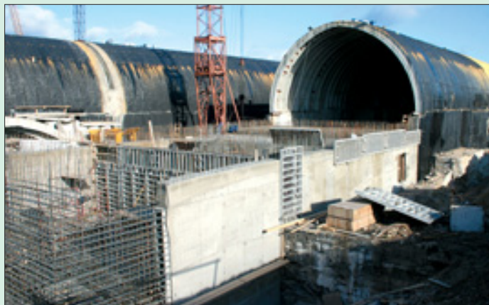
Строительство станции термостатирования (сооружения 10 и 10а)
