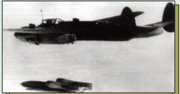
Пуск самолета-снаряда 16ХА «1-го этапа разработки» с борта среднего бомбардировщика Ту-2. Фото: //testpilot.ru
