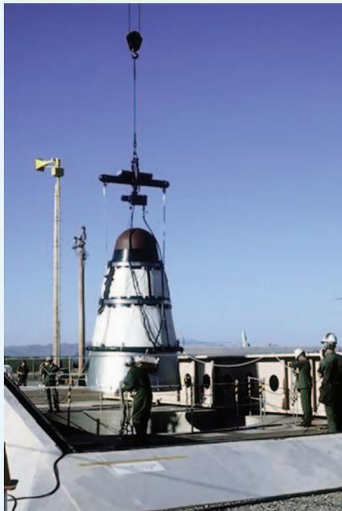
Установка ракеты «Titan» II в пусковую шахту
