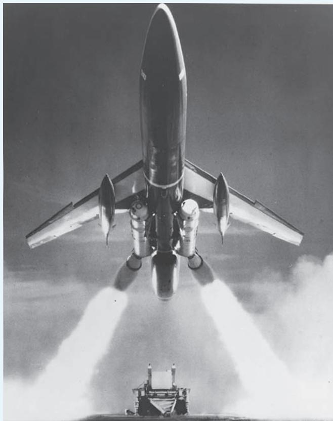
Старт SM-62 Snark с мобильной ПУ с мыса Канаверал. Хорошо видна работа стартовых ускорителей
