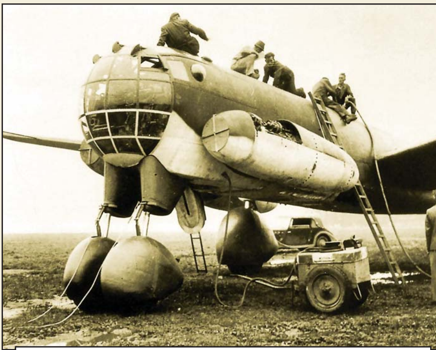
Наземная отработка силовой установки первого опытного самолета Ju 287V1. Фото: http://en.valka.cz
