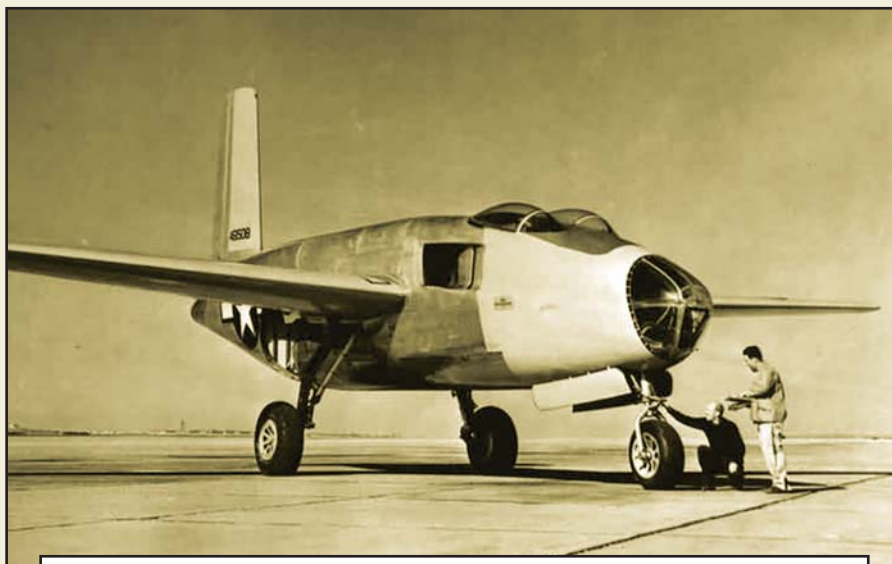
На этом фото хорошо видны воздухозаборники самолета XB-43, не выступающие за мидель фюзеляжа. Тонкая шель спереди — слив погранслоя. Фото: http://1000aircraftphotos.com/Contributions/HornDavid/8826L.jpg
