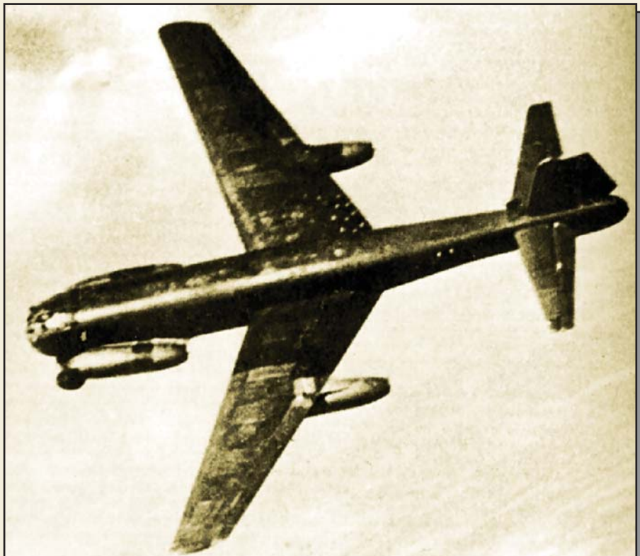
Первый опытный бомбардировщик Ju 287V1 в полете. Хорошо видны его главные особенности — турбореактивная силовая установка и крыло обратной стреловидности. Фото: http://www.wiivehicles.com
