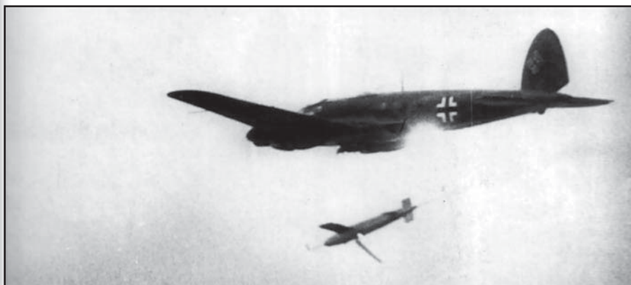
Испытательный пуск опытной планирующей бомбы BV 143 с борта самолета He 111H
