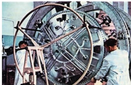
Монтаж двигательного отсека
