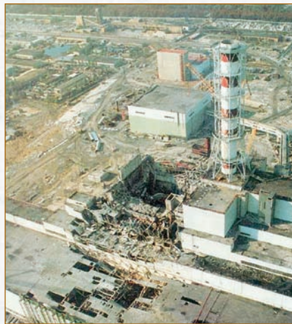
Четвертый энергоблок Чернобыльской АЭС после разрушения.
