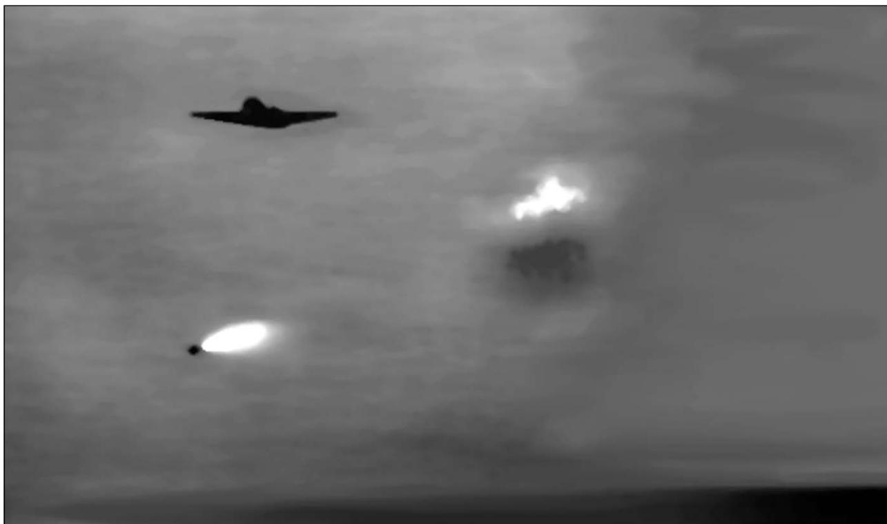
**Испытательный пуск бомбы SB 800. Самолёт-носитель – Fw 190. Сброс произведён с высоты 30–40 м. Облачко на заднем плане образовалось при запуске двигателя бомбы. (Кадр кинохроники.)**
