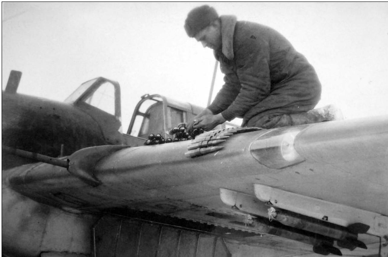
Под крылом Ил-2 два ракетных орудия РО-82 в обтекателях ЦАГИ. Ракетные снаряды РС-82 на середине направляющих. Перед вылетом их сдвинут назад, чтобы пиропистолет вошёл в сопло. Бомболок открыт, техник заряжает пушку.
