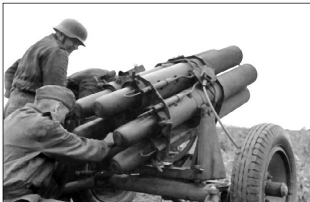
**Пусковая установка, заряженная 150-мм снарядами, на огневой позиции. Хорошо видны боевые части ракет, выступающие за контур направляющих труб. Лето 1942 г. Фото: Нейберле, Федеральный архив ФРГ.**
