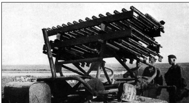
*Установка БМ-8-36, на шасси автомобиля ЗИС-6. Направляющие типа «Флейта» – заряжать можно было только с дульной части. Сверху установлен снаряд. Установка захвачена немецкими войсками в августе 1942 г, Северо-Кавказский фронт.*
