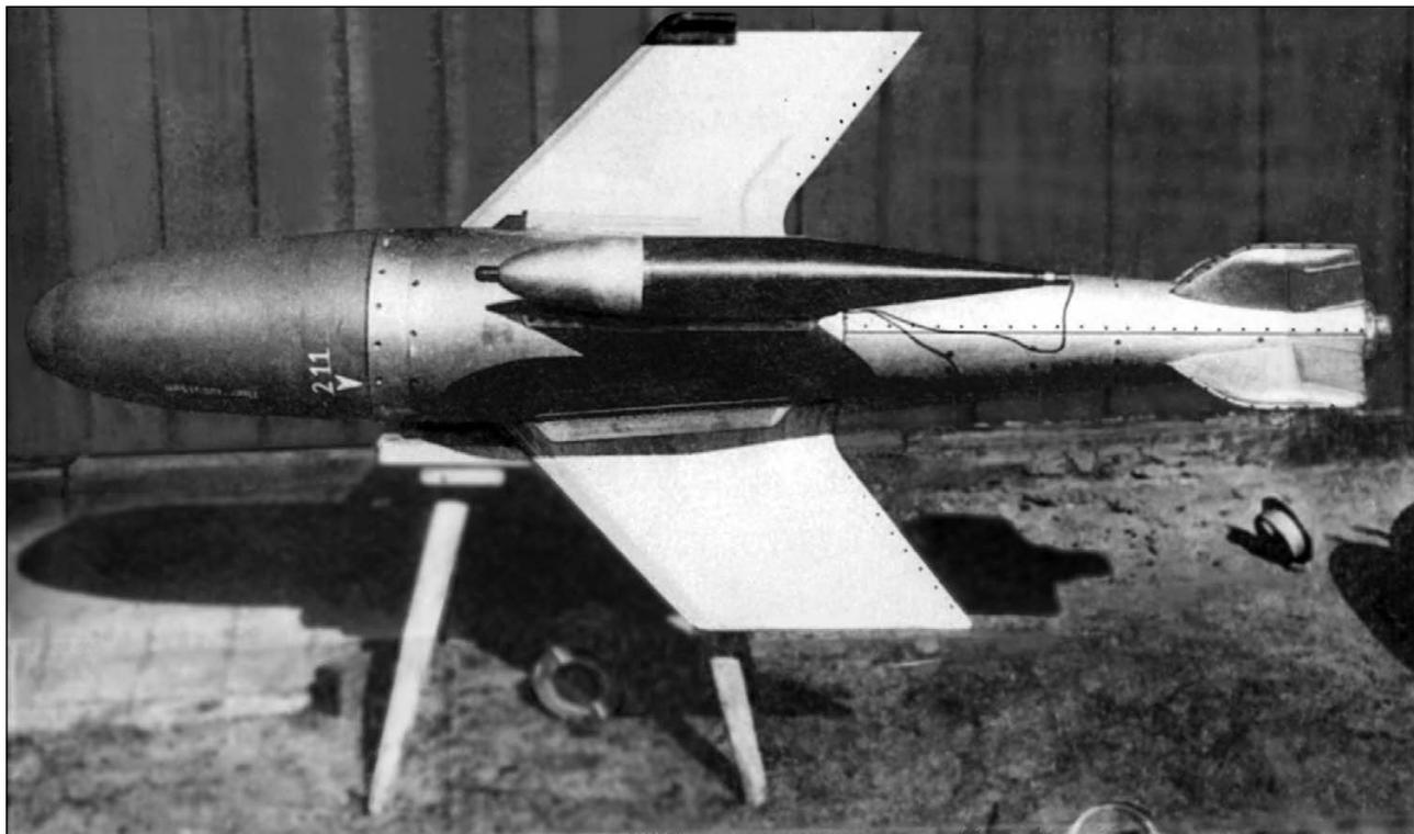
Ракета X-4. Ясно видны три отсека. На среднем отсеке, на уголках, крепятся фанерные крылья. К нему, на винтах, крепятся боевая часть и хвостовой отсек. Два последних отсека свёрнуты из дюралевых листов и собраны на заклёпках. На крыле виден контейнер для управляющего провода, и сам провод выходящий из хвоста контейнера. На верхнем крыле виден кронштейн, для крепления трассера. Стабилизаторы имеют толстый профиль, внутри которого спрятаны механизмы интерцепторов.
