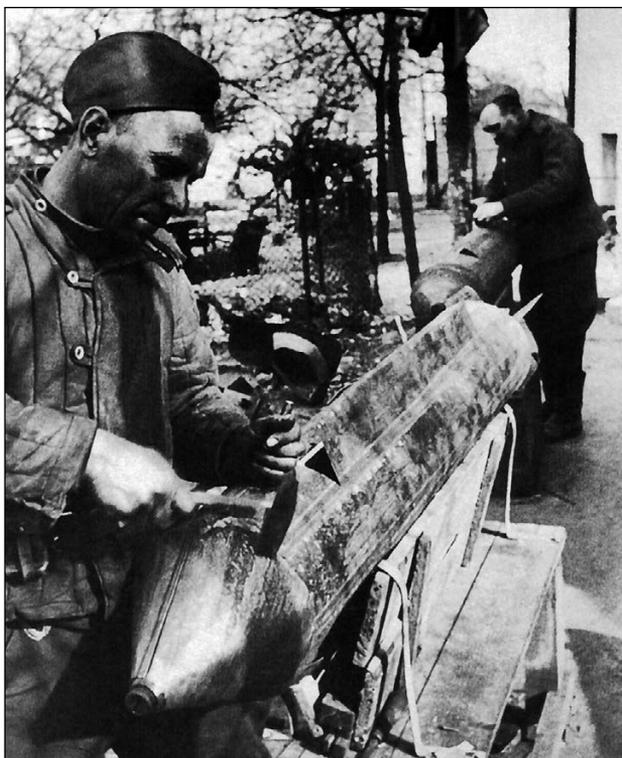
*Изготовление летающих торпед. Кожух, изготовленный из кровельного железа, на гвоздях, крепится к деревянным шпангоутам торпеды. В носу оставлено отверстие для вворачивания взрывателя в М-20. Бреставль, 29 апреля 1945 г.*
