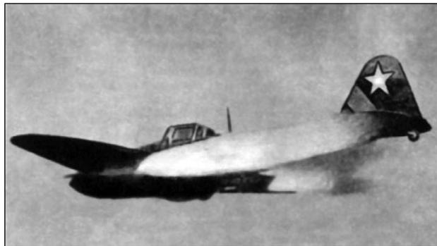
Пуск снарядов РС-132 с одноместного штурмовика Ил-2.
