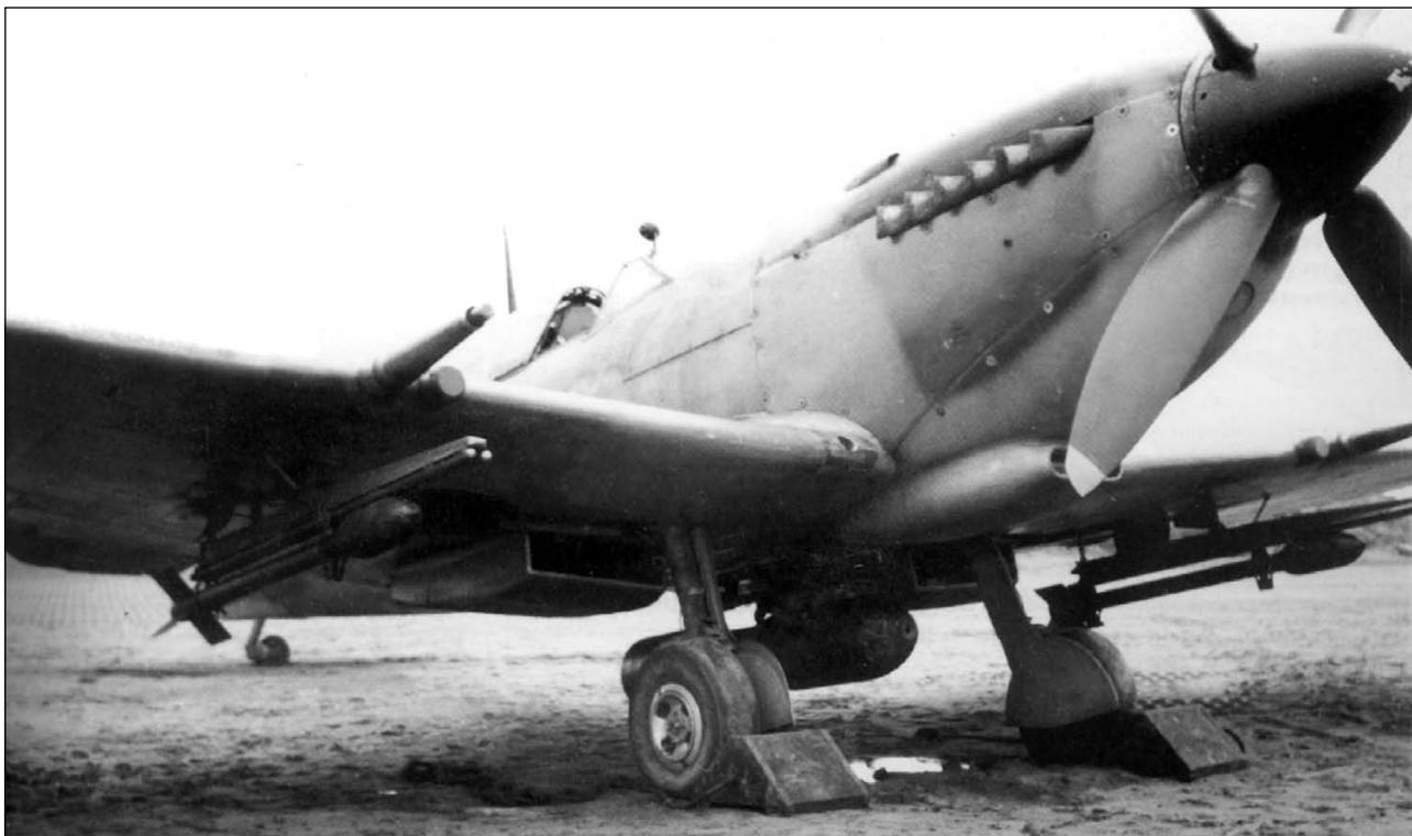
*Спитфайер LF.IXЕ или XVIЕ, снаряжённый для выполнения штурмовых задач. Под крылом ракеты с 60-фунтовой (27 кг) БЧ, а под фюзеляжем – 500-фунтовая бомба (225 кг). Один из аэродромов в Голландии. 1945 г.*
