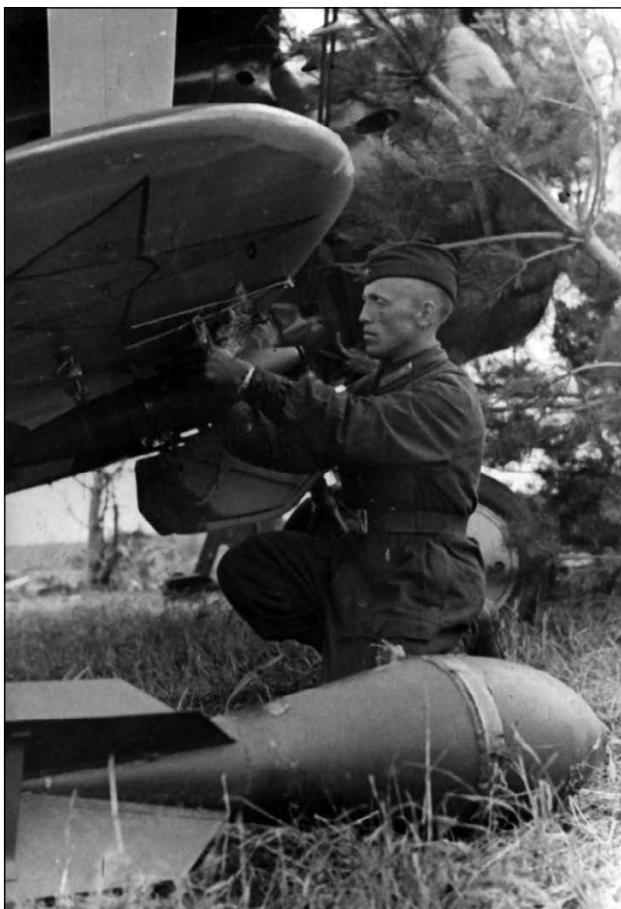
**Снаряды РС-132 под крылом самолёта Ил-2 из 312-го штурмового авиационного полка. Зима 1941/42 г. (?).**
