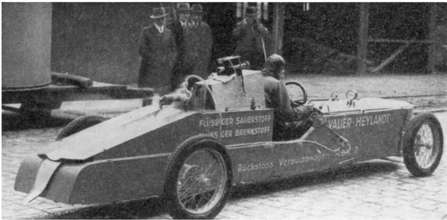
Bild 4: Die letzte Ausführung eines Raketen-Versuchsaautos von Max Valier mit Flüssigkeitsrakete. Die Raketenbrennkammer ist oberhalb der Hinterachse angebracht; der austretende Feuerstrahl ist auf dem Bild ebenfalls schwach sichtbar. Die öffentliche Vorführung dieses Autos fand nicht mehr statt, da Valier vorher tödlich verunglückte
