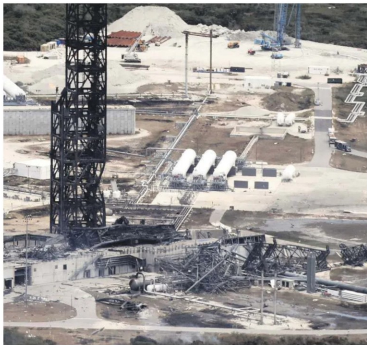
Das Startgelände LC-36 am Cape Canaveral nach der Explosion der New Glenn.
