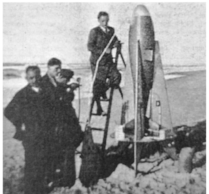
Betankt wurde die HW II mit Sauerstoff und Methan, der erste Startversuch mißglückte im Herbst 1932 (u.).
