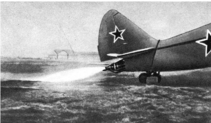
Das Flugzeug Pe-2R mit dem Triebwerk RD-1 (1943). Insgesamt absolvierte die Pe-2R 169 Brennstarts mit RD-1 und RD-1X3 (1943—1945)
