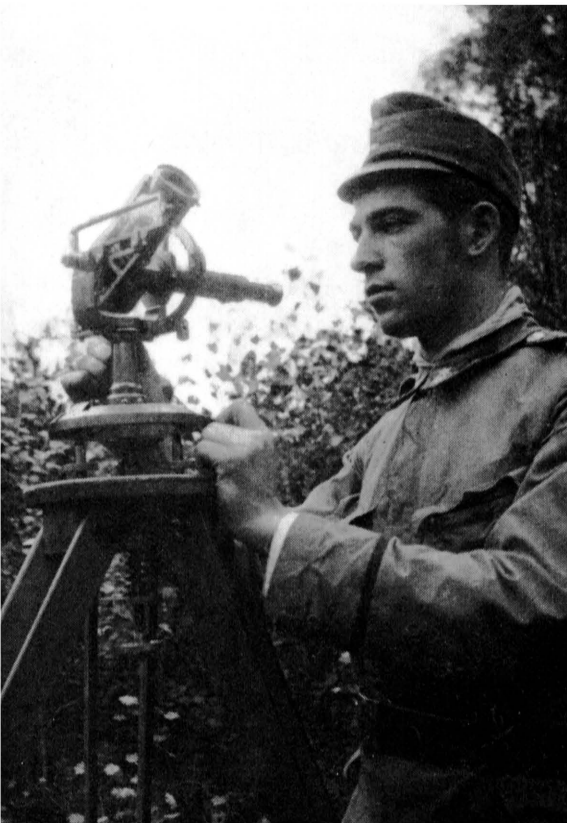
Valier am Richtkreis- Theodolit für Luftab- wehr, österr.-italien. Front.
