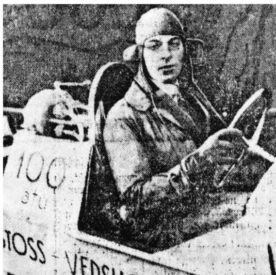
Versuchsfahrt mit Flüssigkohlenensäure- Antrieb.
