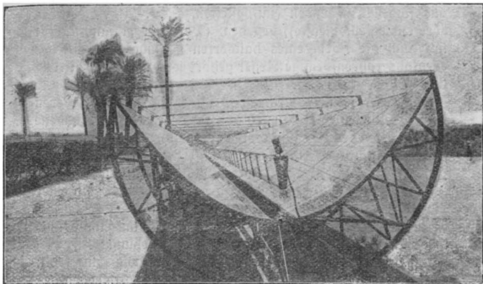
Abb. 13. Einer der fünf Strahlensammler des Sonnenkraftwerkes in Meadi (Ägypten). In der Achse des Parabolspiegels der lange flache Dampfessel (Verdampfer). Die Abbildung zeigt die Spiegelstellung zur Mittagszeit.
