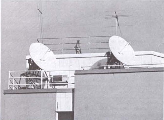
Figure 1 — Antennes de radiomètres à 11 et 14 GHz, installées sur le toit du siège de l'Administration suédoise des Télécommunications à Farsta, Stockholm.
