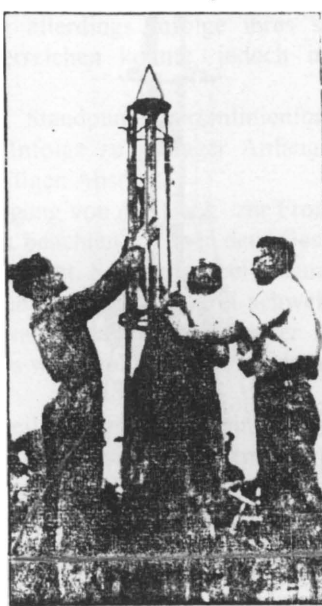
Erster öffentlicher Raketenstart auf der Vahrenwalder Heide in Hannover. Der Konstrukteur Püllenberg mit seinen Assistenten setzt die Flüssigkeitsrakete in die Lauchschiene ein
