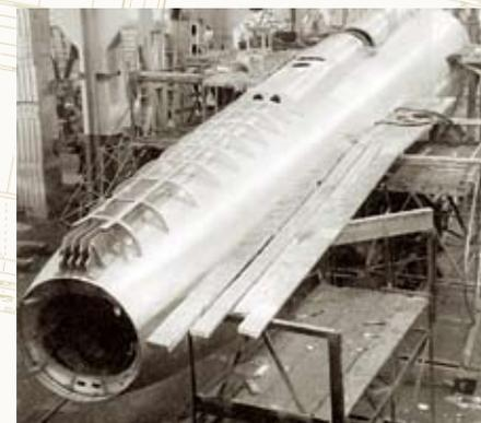
▲ **Сборка хвостовой части бомбардировщика М-50 в цехе завода № 23**
