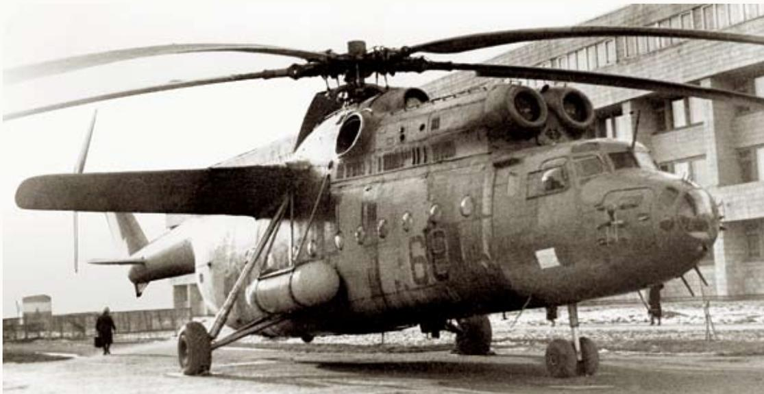
▲ **Ми-6 – многоцелевой вертолет конструкции М.Л. Милья. Серийно производился в 1960–1962 гг. – (50 машин) до перевода завода на выпуск ракетно-космической техники. По своим ТТХ вертолет – уникальная машина своего времени: 12 т груза в кабине (или 9 т на подвеске), или 70 солдат со снаряжением, или 90 пассажиров, крейсерская скорость 250 км/ч, дальность до 1000 км.**
