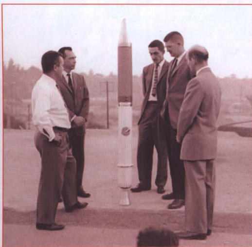
Макет ИСЗ "Эксплорер-1" с четвертой ступенью (вверху). Внизу вторая ступень, в центре которой размещена третья ступень. Справа - американские инженеры у макета спутника
