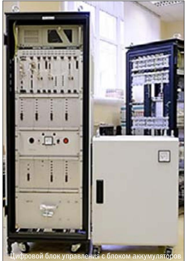
Цифровой блок управления с блоком аккумуляторов
