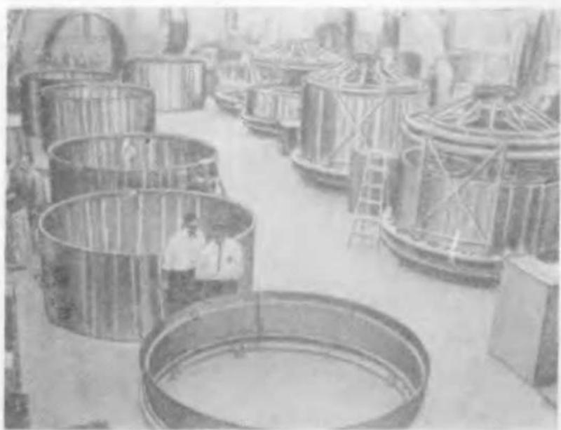
Рис. 27. Отдельные цилиндрические секции баков свариваются попарно. Для сохранения цилиндрической формы сварных секций применяют складные кольцевые опоры
