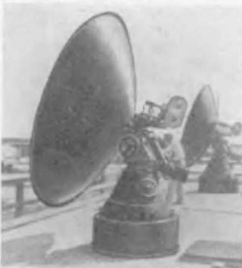
Рис. 47. Установка антенн радиолокатора и киносъемочных камер на мысе Канаверал, используемых для слежения за баллистическими ракетами
