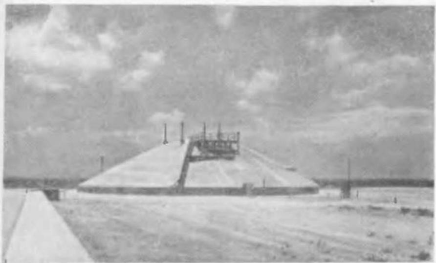
Рис. 45. Блокгауз пункта управления стартового комплекса ракет «Атлас» на мысе Канаверал. Его стены имеют толщину 1,8 м, а сводчатая крыша из железобетона покрыта трехметровым слоем песка. Из крыши выступают перископы для наблюдения за ракетой, находящейся на стартовом столе
