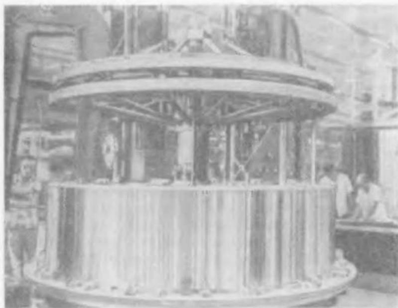
Рис. 26. Одна из секций бака ракеты «Атлас». Автоматическая сварочная машина сваривает встык края стального листа, обтянутого на цилиндрической оправке. Сварной шов усиливается изнутри узкой полоской из нержавеющей стали
