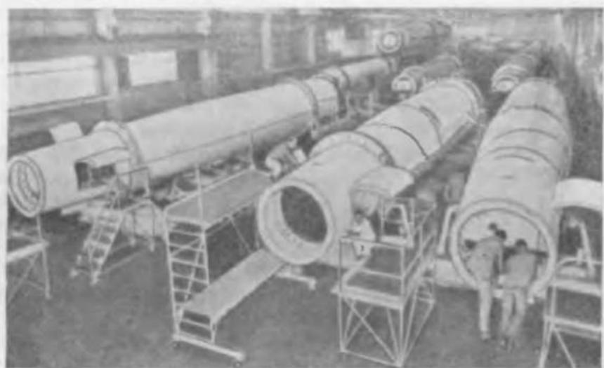
Рис. 8. Сборка ракет «Тор» на заводе фирмы «Дуглас» в Санта-Монике
