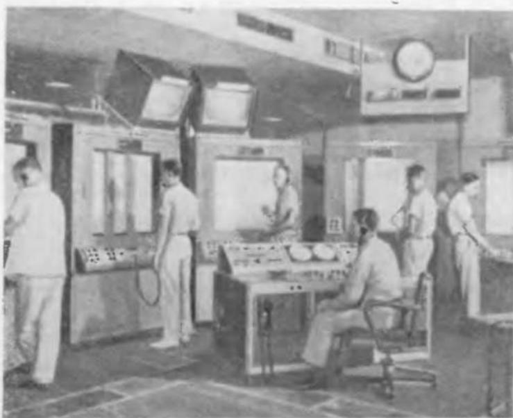
Рис. 43. Во время полета баллистической ракеты на Атлантическом ракетном полигоне офицер безопасности на полигоне следит за траекторией полета ракеты по ее следу на планшетных устройствах. Он может дать команду о подрыве ракеты, если она отклонится от заданного курса
