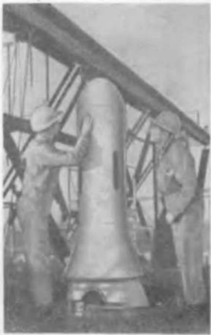
Рис. 37. Головная часть типа RVX-1, установленная на ракете «Тор-Эйбл», подготавливается к испытательному полету на мысе Канаверал
