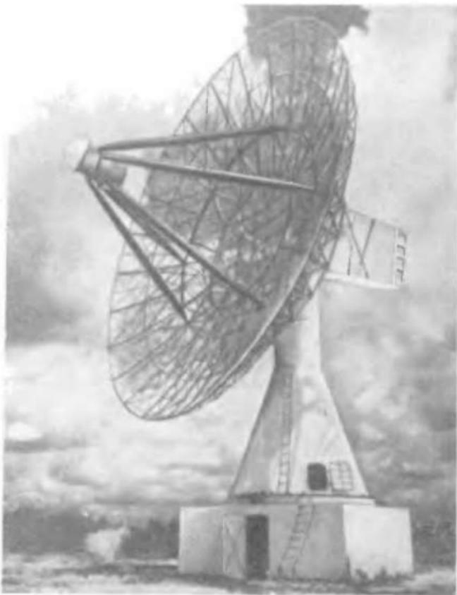
Рис. 49. Антенна телеметрической системы автоматического слежения представляет собой 18-м чашу на стальной башне высотой 11,6 м. Следящая антenna TLM-18, установленная на Атлантическом ракетном полигоне, может следить за баллистическими ракетами на значительном расстоянии
