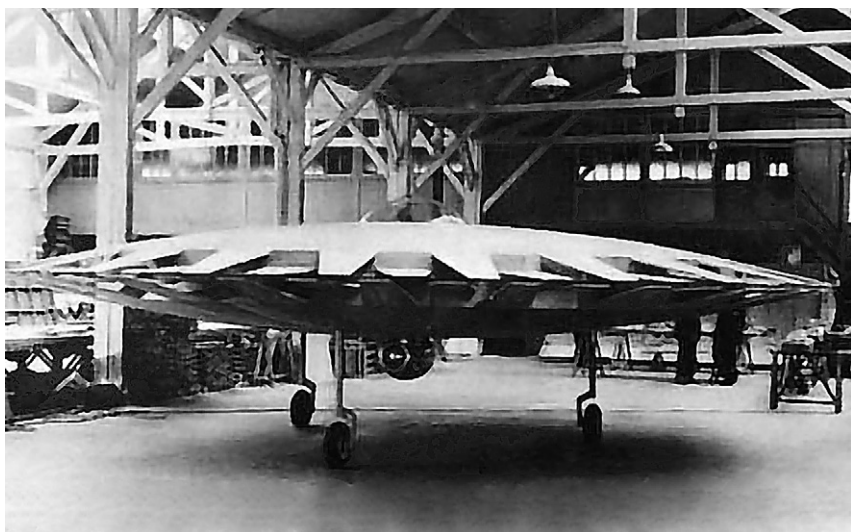
«Аэродин» со снятым покрытием верхней части
