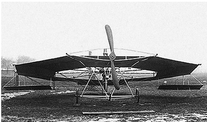
«Зонтик» Воута-Мак-Кормика (пропеллер перед крылом)
