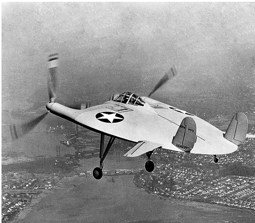
V-173 в полёте. Его шасси не убиралось
