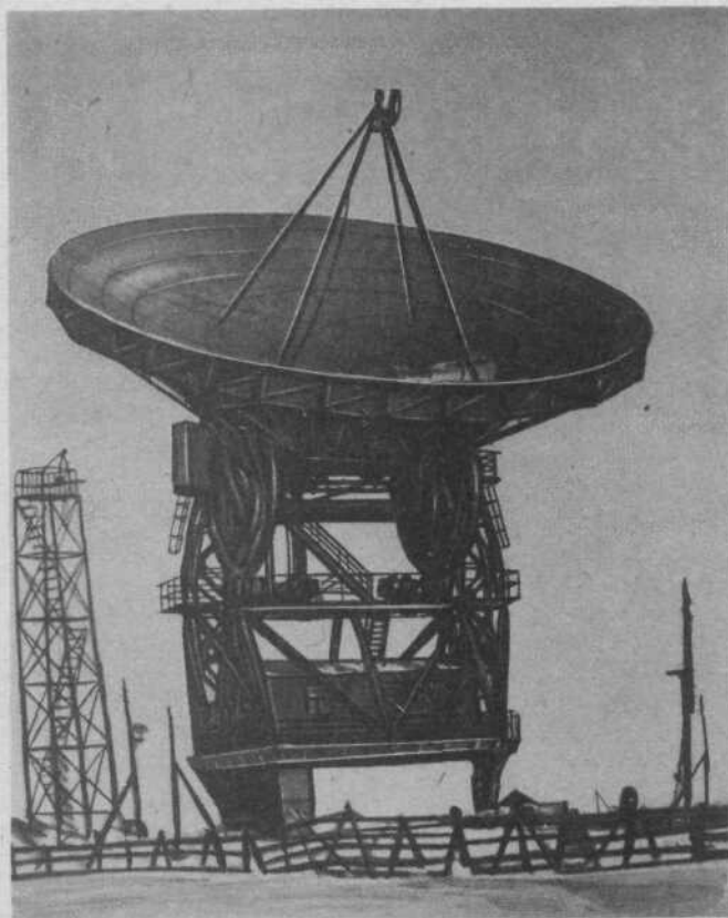
Рис. 91. Серпуховский радиотелескоп Физического института Академии наук СССР (диаметр зеркала 22 м)
