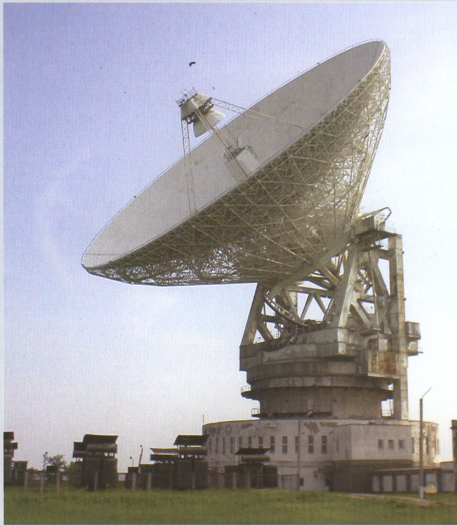
Антенна П-2500 диаметром 70 м. Используется для дальней космической связи и научных исследований. Установлена в Западном и Восточном центрах дальней космической связи в Евпатории (1978 г.), в Уссурийске (1986 г.).
