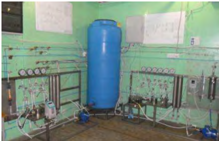
Рис. 12. Стенд для наземной отработки системы кислородообеспечения
