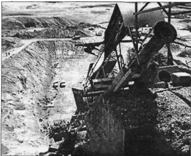
Строительная площадка проекта «Вавилон»
