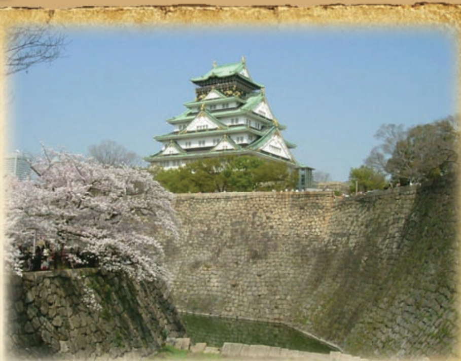
Внутренний ров и стена замка Осака, за которыми видна центральная башня - тэнсю (тэнсюкаку). Она являлась последним укрытием для осажденных и жилищем даймё и его семьи. Поскольку укладывались камни без связующего раствора, то угол наклона стен был довольно значительный
