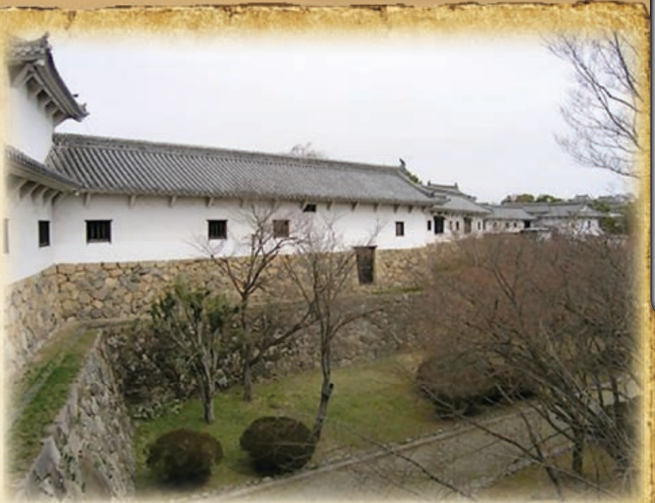
Стена с внутренней стороны. Вдоль стены - длинная узкая галерея, по которой могли ходить обороняющиеся
