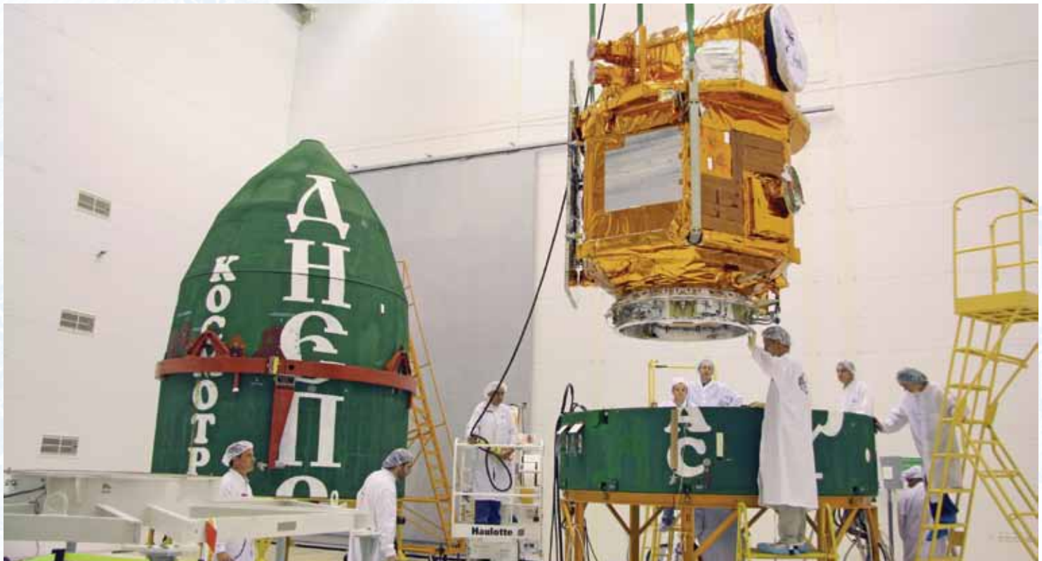
Установка спутника в космическую головную часть РН «Днепр»
