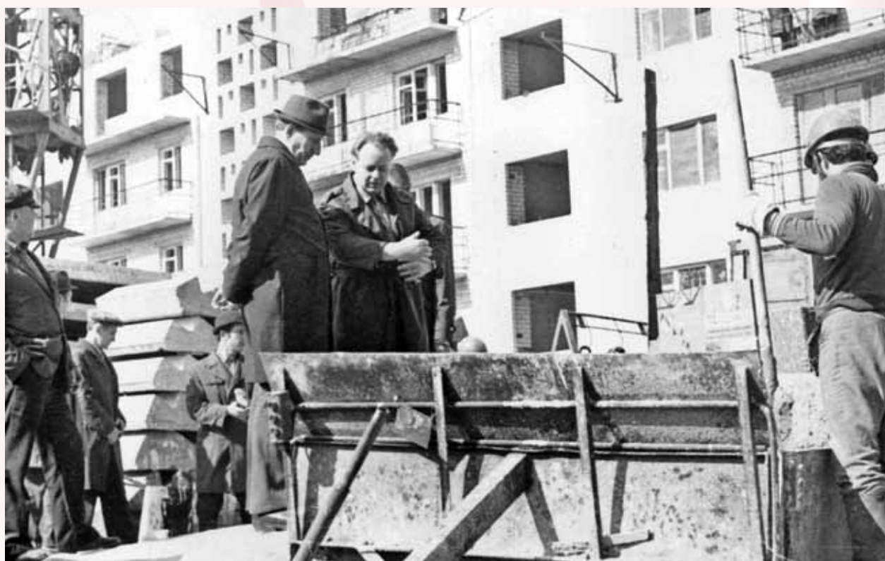
В.Ф. Уткин на строительной площадке. С 1971 по 1990 год для сотрудников КБ «Южное» было построено более 2000 квартир
