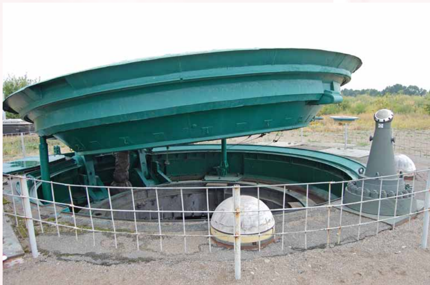
Закрывается многотонная крыша ШПУ. Справа – приемные антенны системы боевого управления
