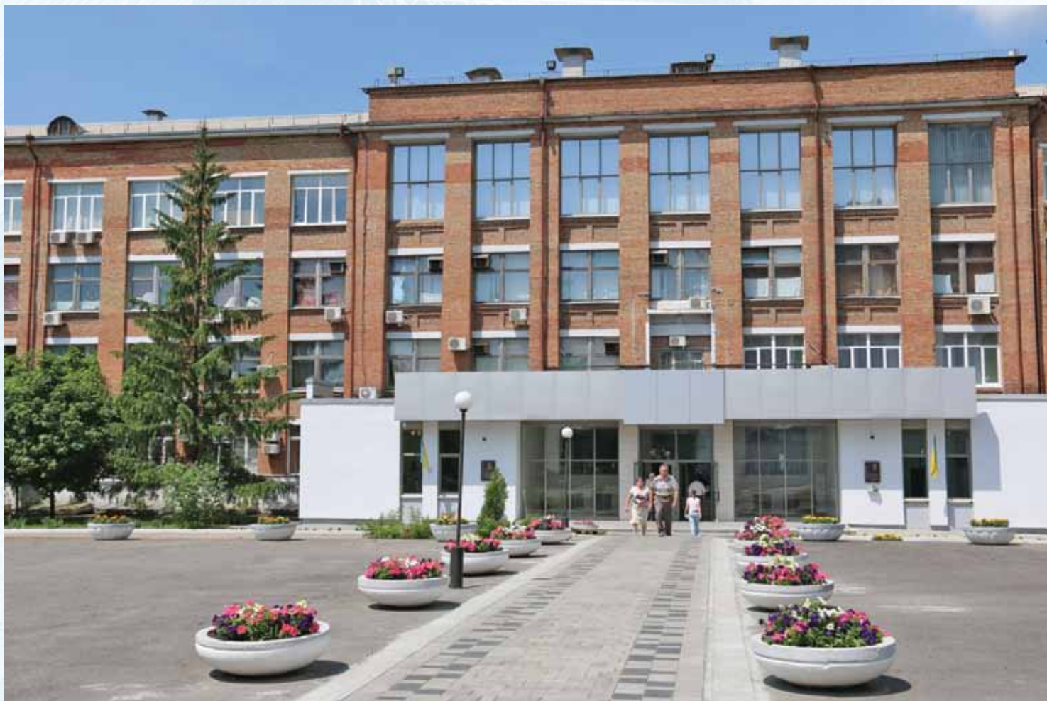
Инженерный корпус КБ «Южное» после ремонта
