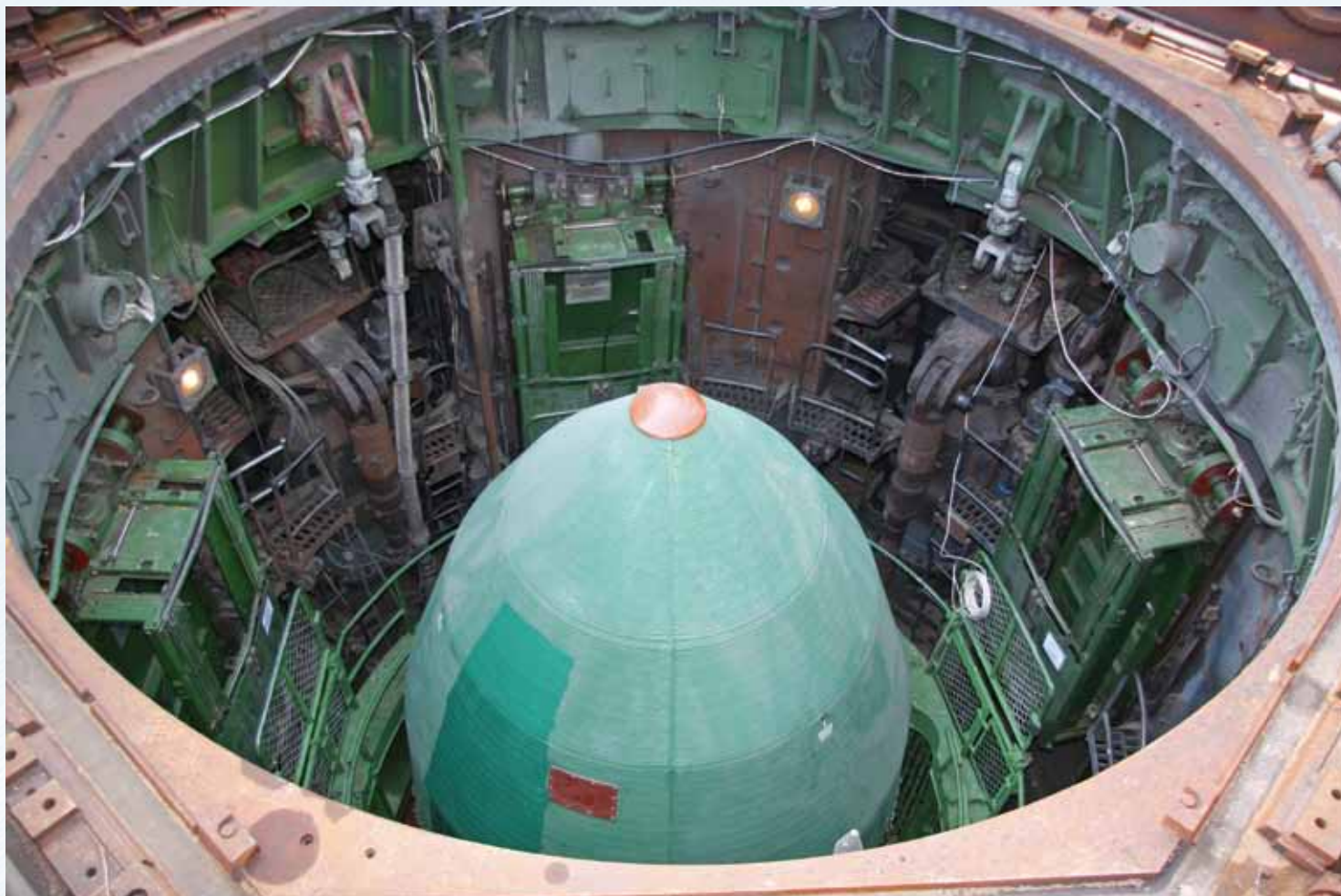
РН «Днепр» в шахтной пусковой установке на космодроме Байконур
