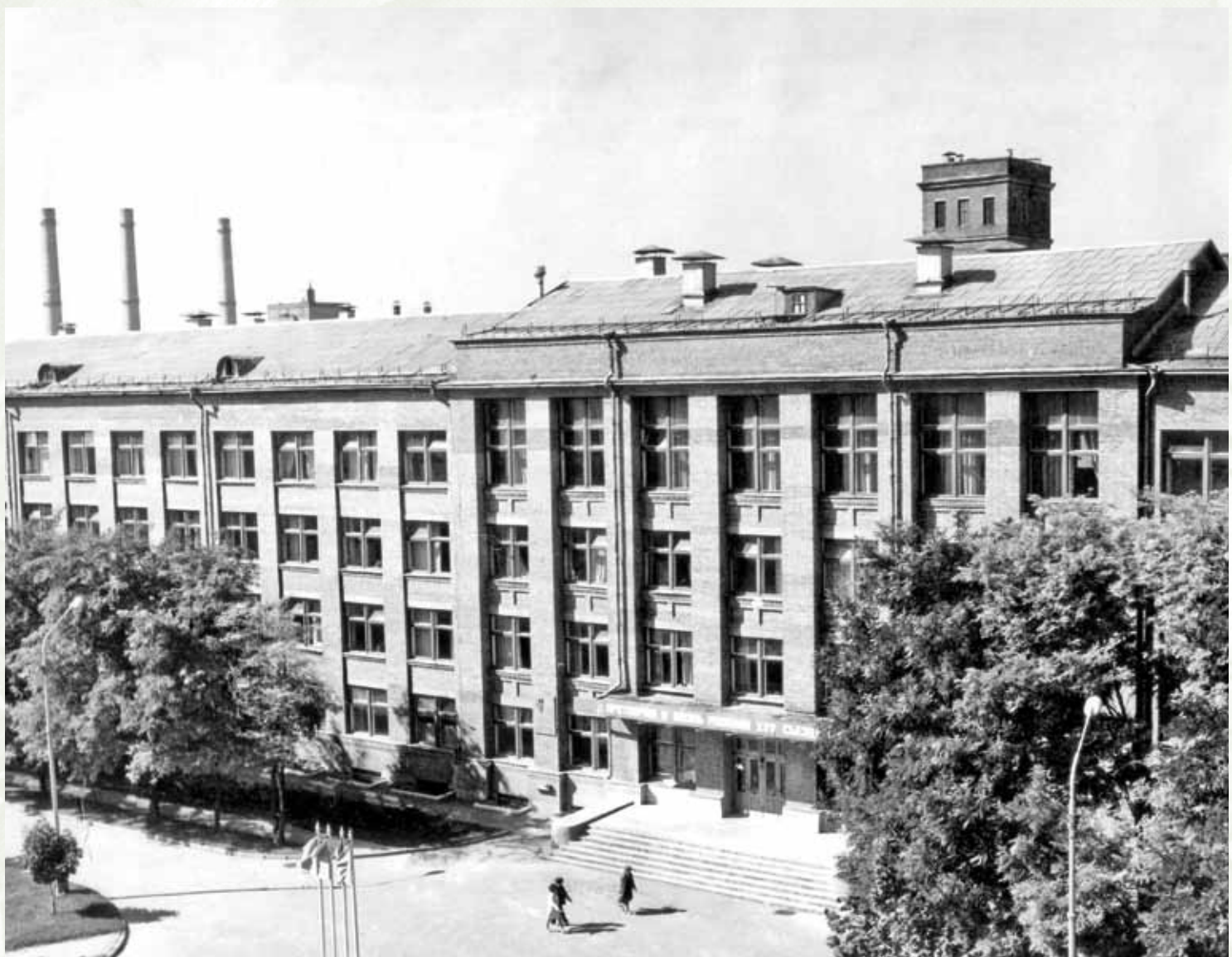
Второй собственный корпус ОКБ-586 (инженерный корпус №88)
