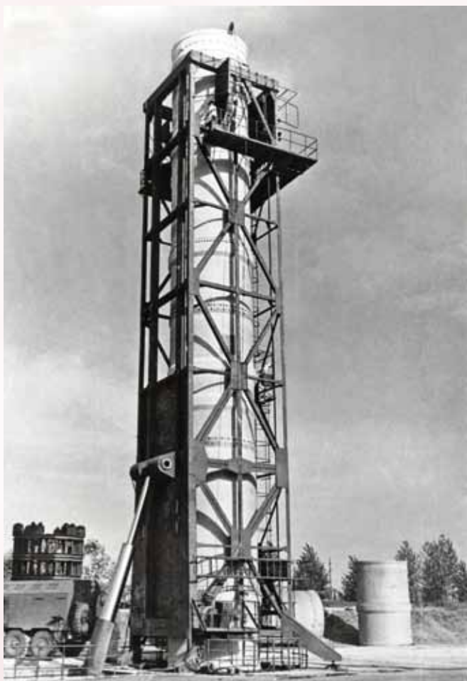
Стенд для проведения бросковых испытаний макетов ракет на полигоне Павлоградского механического завода, начало 1970-х
