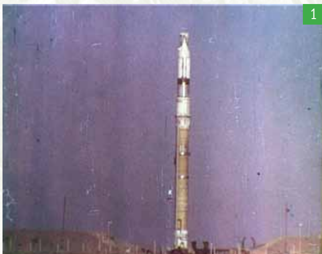
Кадры киносъемки первых бросковых испытаний (БИ-2) макета тяжелой ракеты Р-36М из транспортно-пускового контейнера по минометной схеме. Полигон Байконур, 22 октября 1971 года
