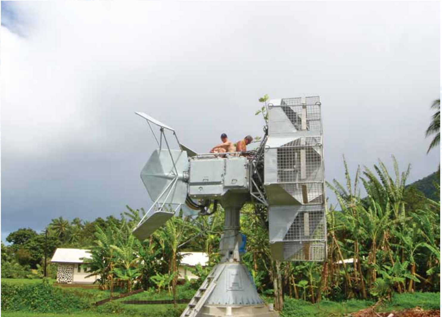
Монтаж выносного измерительного пункта (ВИП) в приэкваториальной зоне
