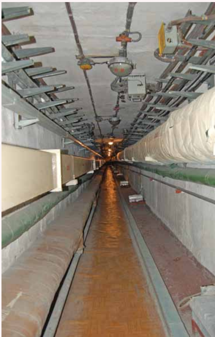
Подземный тоннель (патерна) для прохода к командному пункту
