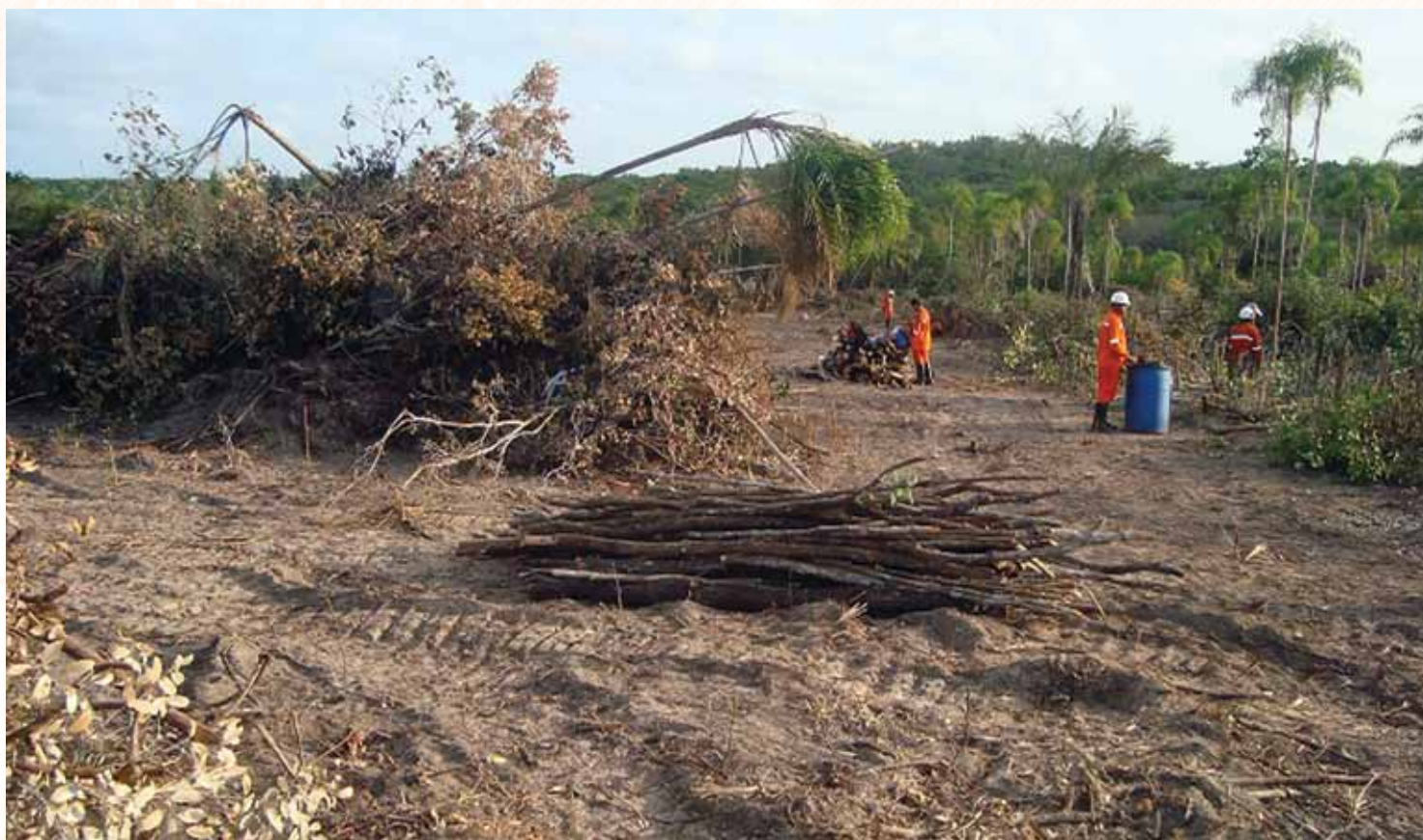
Вырубка деревьев перед началом строительства наземного комплекса КРК «Циклон-4», октябрь 2010 года
