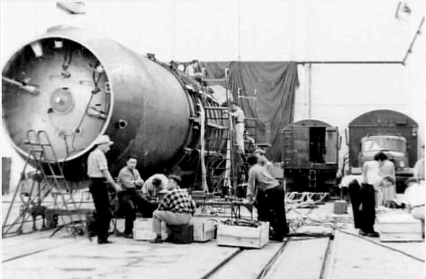
Подготовка ракеты Р-16 в монтажно-испытательном корпусе на Байконуре
