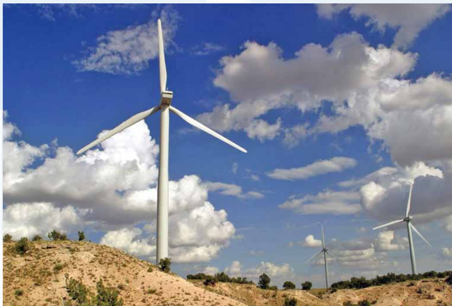
В декабре 1993 года начато строительство трех украинских ветроэлектростанций с ветроагрегатами АВЭ-250С разработки КБ «Южное»
