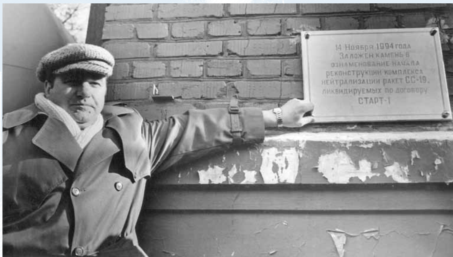
Начальник комплекса эксплуатации ракетно-космических систем КБ «Южное» В.И. Сокол на закладке первого камня комплекса нейтрализации ракет SS-19, 14 ноября 1994 года
